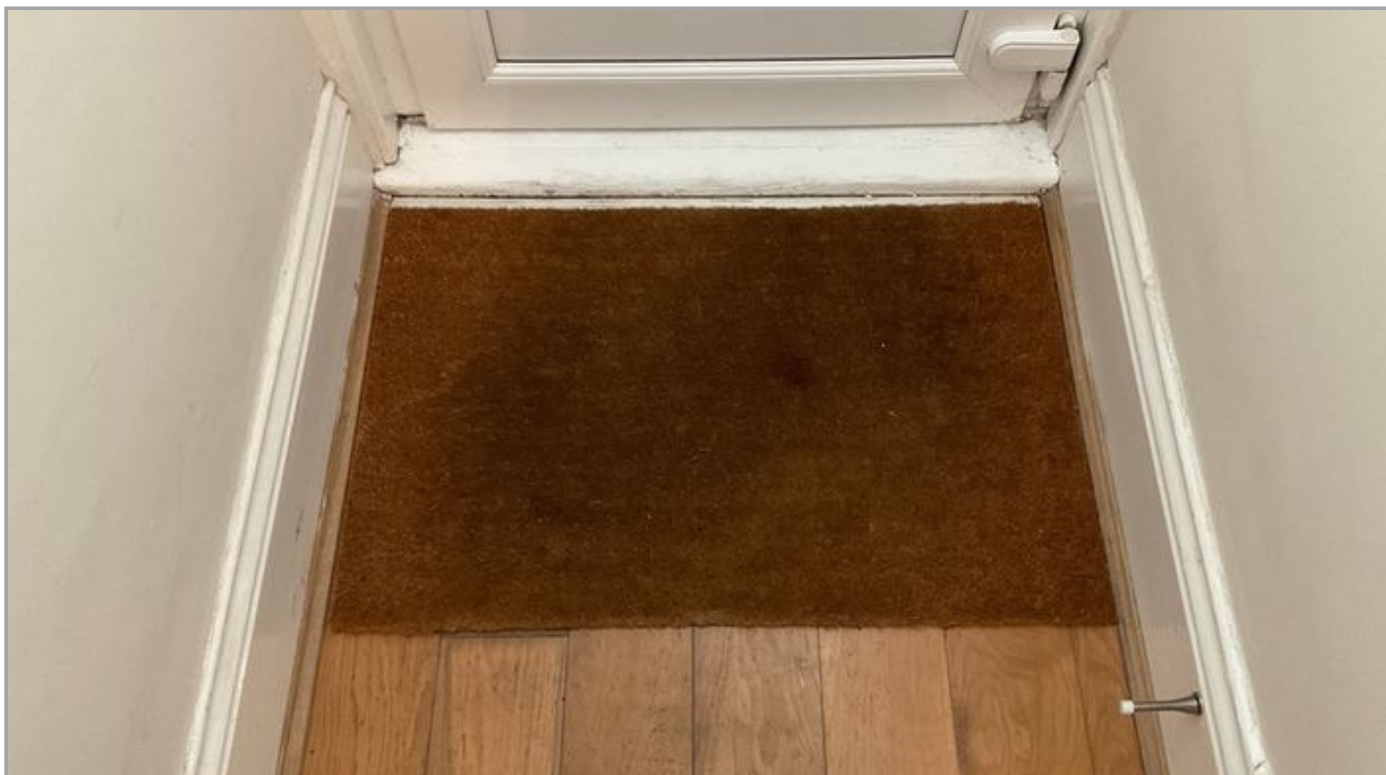
Springy Flooring Hallway
